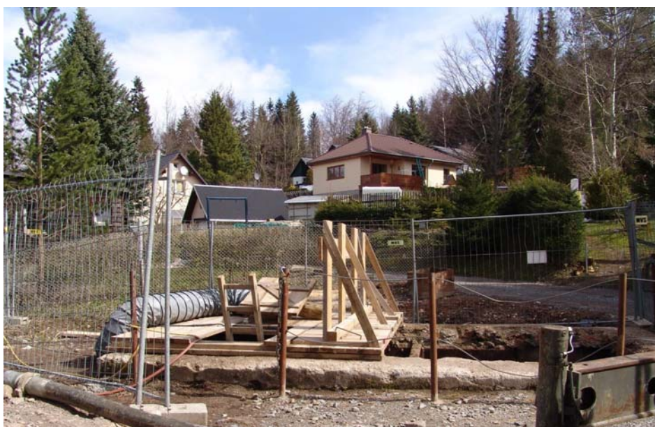
Sanierung Schacht 308 in Schwarzenberg (Foto: Wismut GmbH)
