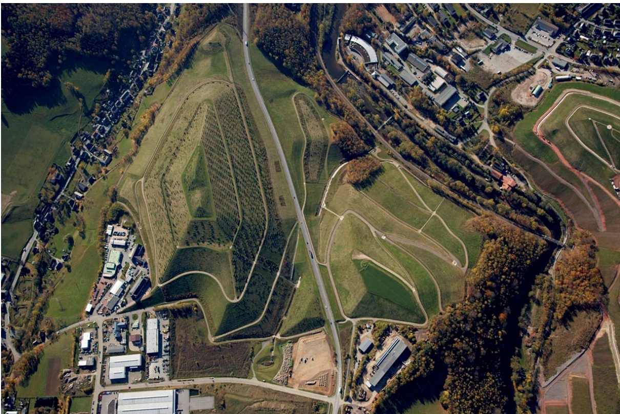
Sanierung Halde 366 Kurbad Schlema (Foto: Wismut GmbH)
