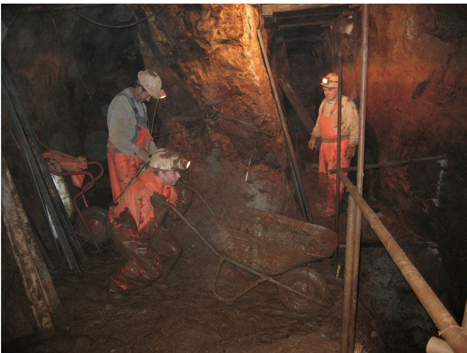
Berufspraktische Ausbildung zum Berg- und Maschinenmann bei Sicherungs- und Verwahrungsarbeiten im Altbergbau (Foto: Bergsicherung Freital)
