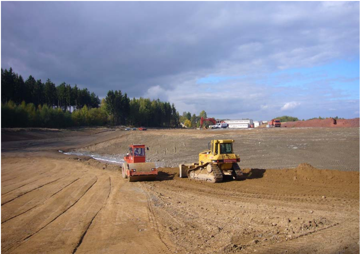
Sanierung Spülhalde am Standort Ehrenfriedersdorf (Foto: GVV mbH)
