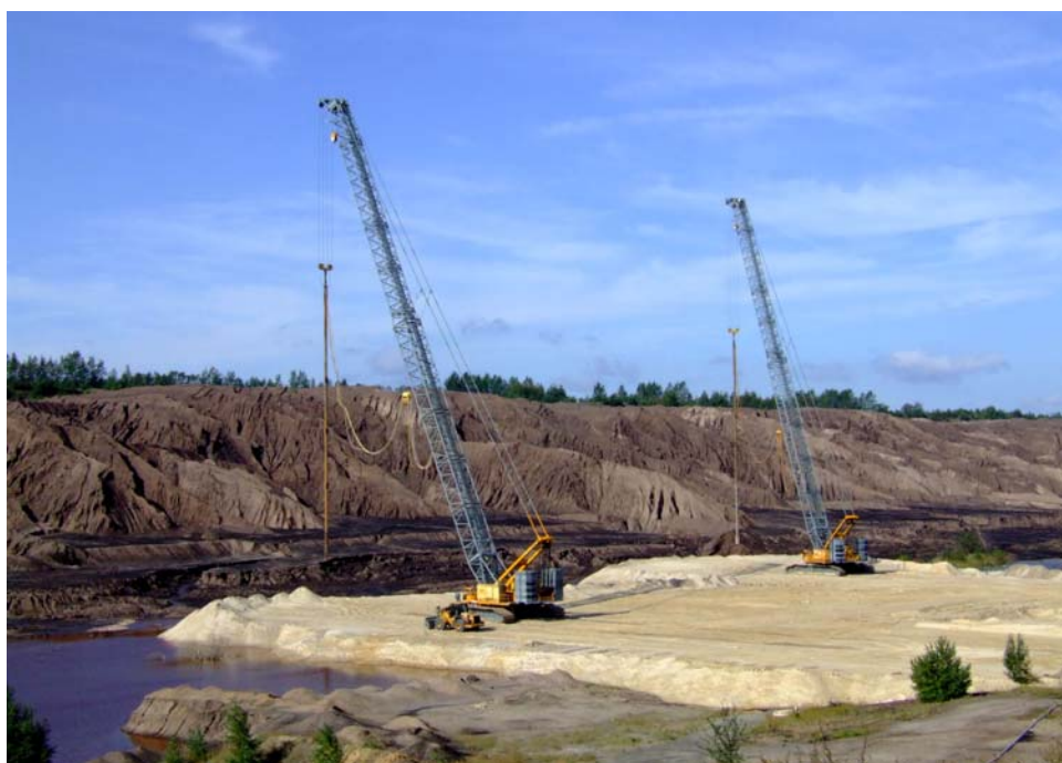
Einsatz von Tiefenrüttlern bei Sanierungsmaßnahmen (Foto: LMBV mbH)
