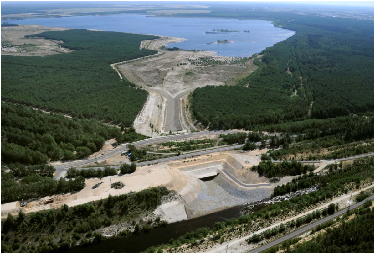
Bau der schiffbaren Verbindung zwischen dem Partwitzer See und Neuwieser See (Foto: LMBV mbH)
