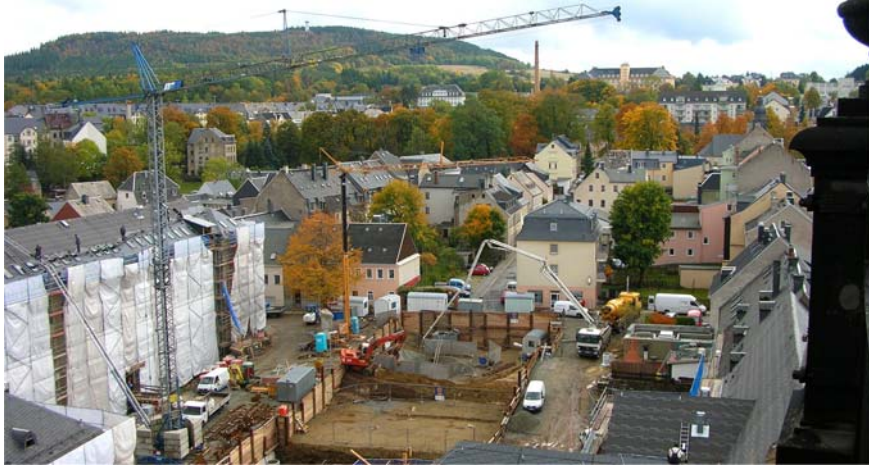
Sicherungs- und Verwahrungsarbeiten an der Baustelle Schulzentrum „Adam Ries“ in Annaberg-Buchholz (Foto: Sächsisches Oberbergamt)
