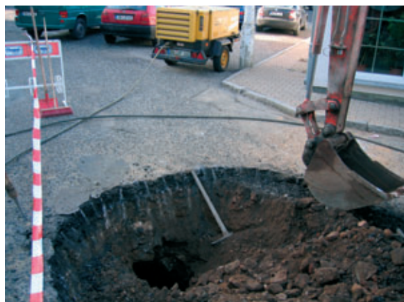
Herstellen einer Vorteufo auf dem Obertorplatz in Dippoldiswalde (Foto: Sächsisches Oberbergamt)
