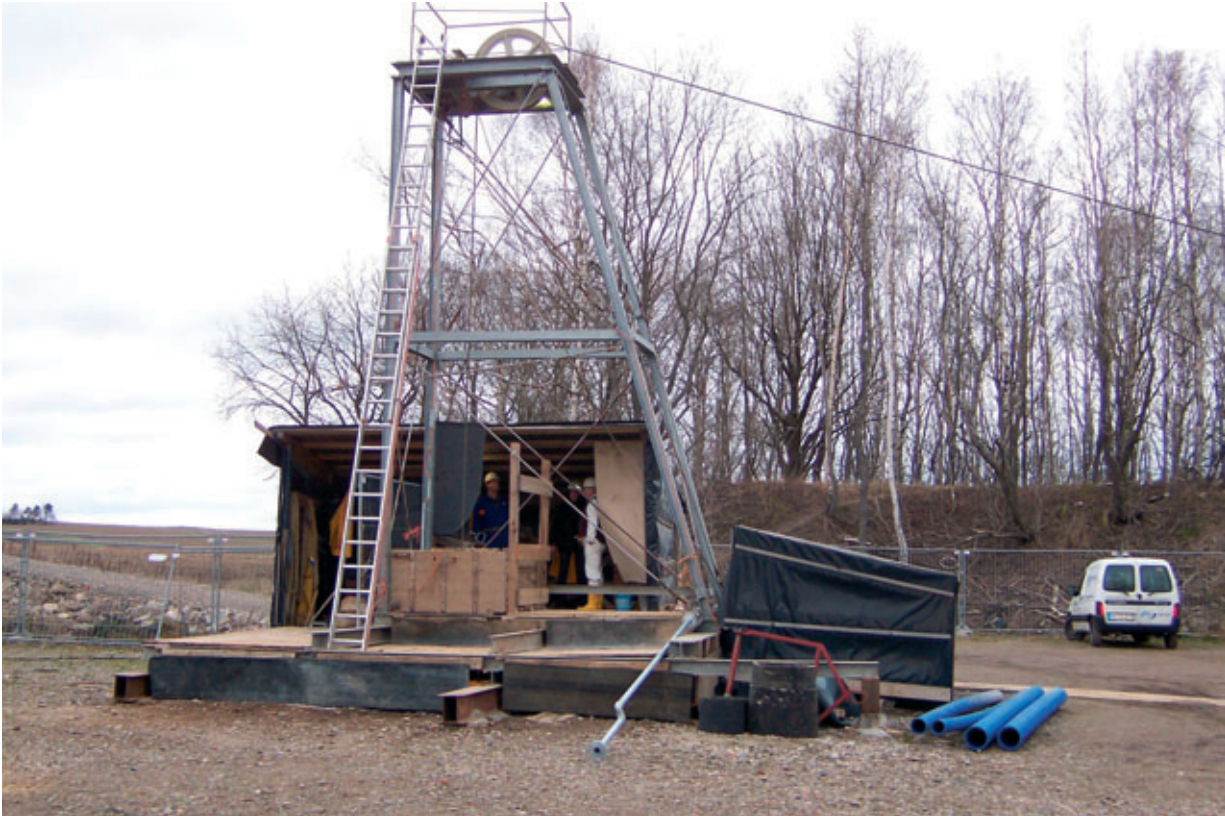
Förderanlage über dem Schacht 302 (Foto: Wismut GmbH)
