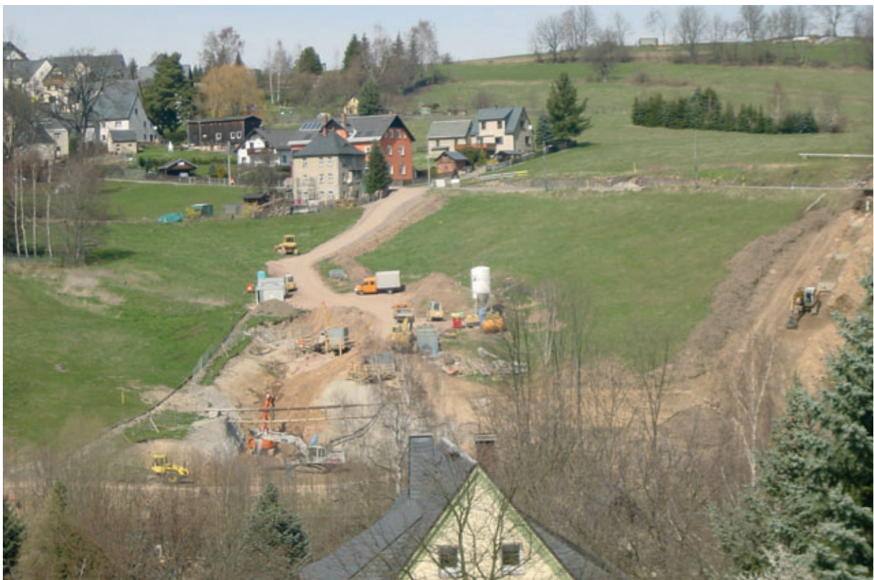
Altbergbausanierung im Bereich des Neubaus der K 9130 Bermsgrün (Foto: Sächsisches Oberbergamt)
