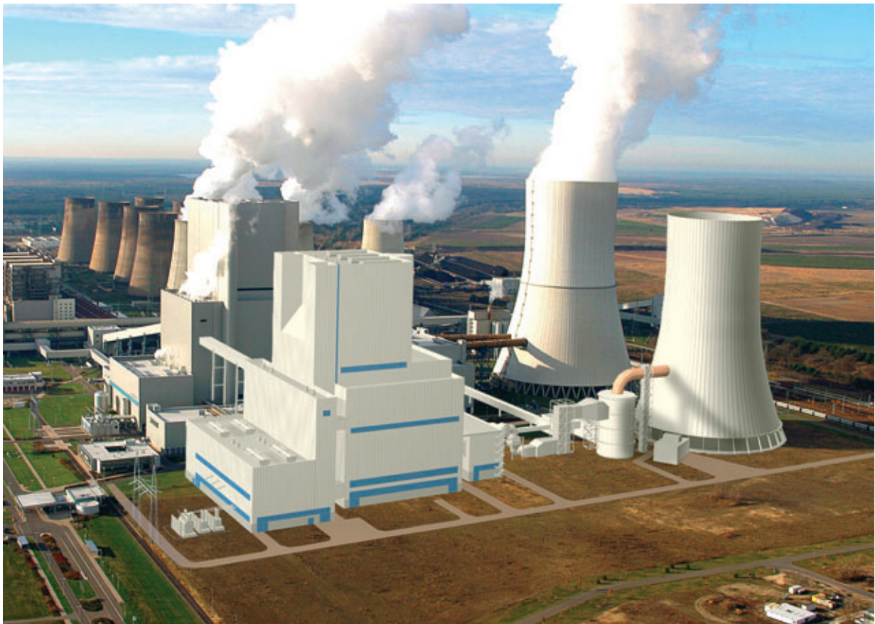
Kraftwerk Boxberg – Bildmontage mit dem Neubaublock Box R (Foto: Vattenfall Europe Mining & Generation)
