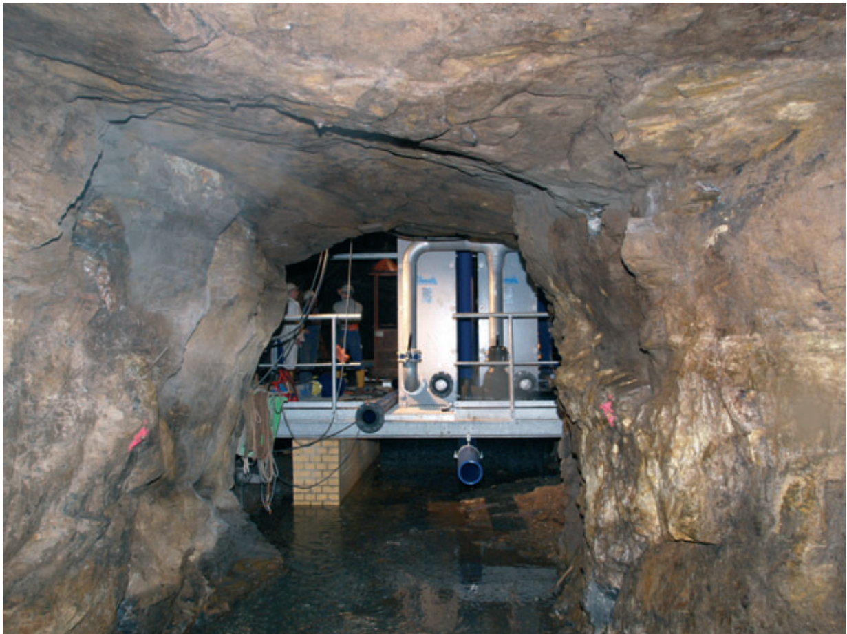
Errichtung der Geothermieanlage im Schacht 302 (Foto: Wismut GmbH)
