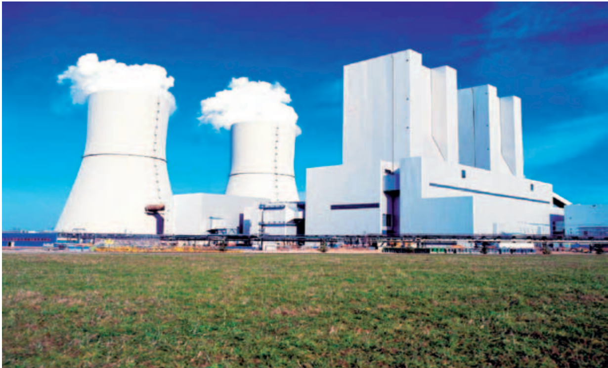
Kraftwerk Lippendorf (Foto: MIBRAG)
