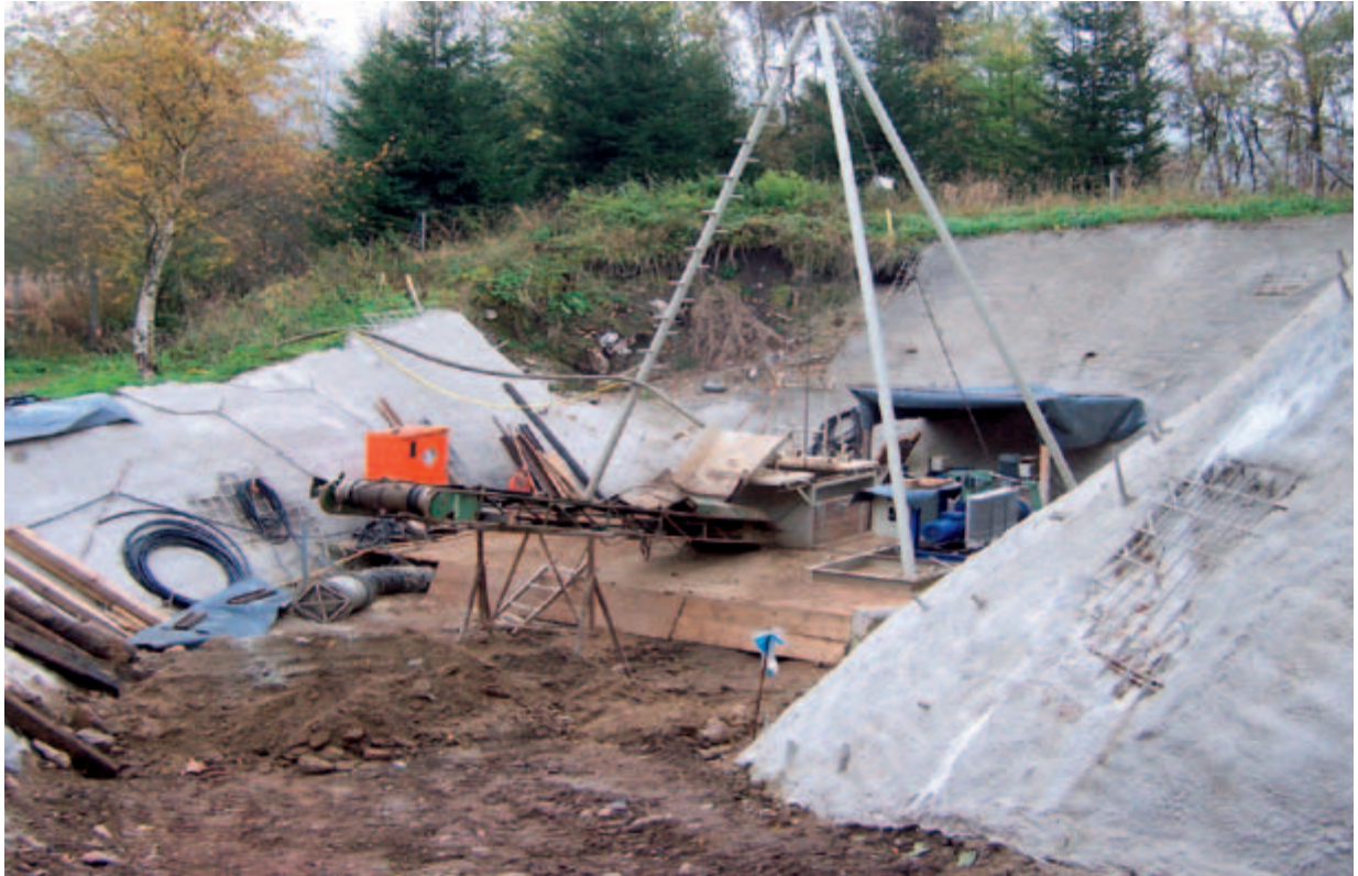
Verwahrarbeiten im Bereich Schacht 245 Oberwiesenthal (Foto: Sächsisches Oberbergamt)
