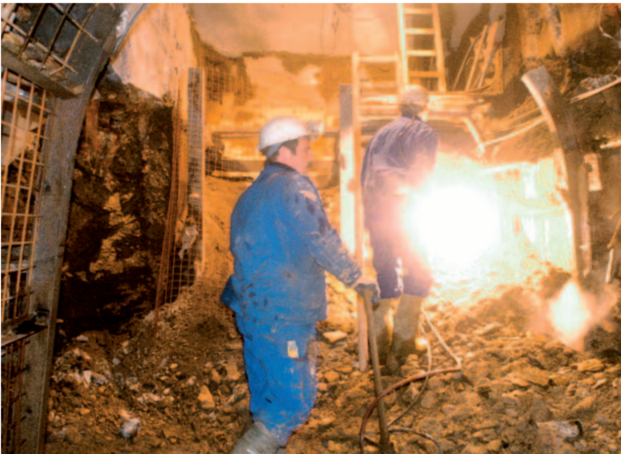
Grube Schlema-Alberoda: Rekonstruktion Schacht 15IIb (Foto: Wismut GmbH)
