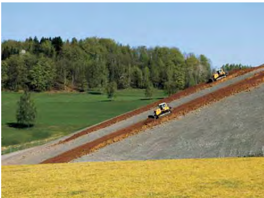
Arbeiten am Speicherbecken der Industriellen Absetzanlage Helmsdorf (Foto: Wismut GmbH)
