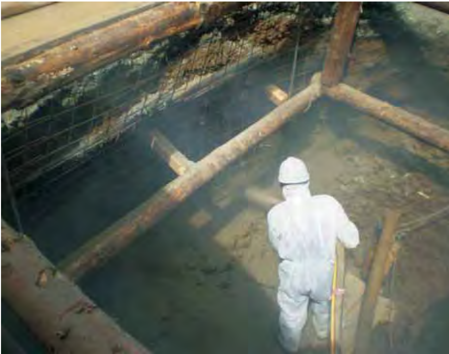
oben: Sicherungsmaßnahmen am Auferstehung Christi Stolln Arnsfeld (Foto: BTOe Bergbau und Tiefbau GmbH Oelsnitz)
