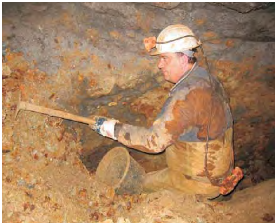
oben: Beräumung von Massen in einem Grubenbau (Foto: Bergsicherung Freital GmbH)
