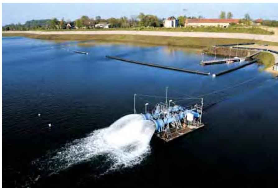
NeiBeeinflauf zur Flutung des Berzdorfer Sees (Foto: LMBV)
