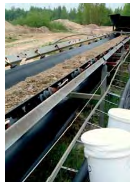
Probenahme vom Förderband einer Nassauskiesungsanlage: Die Positionsdaten des Fördergerätes sowie die Entnahmetiefe gewährleisten die lokale Zuordnung des Rohstoffs (Foto: Kaufmann, LfULG)
