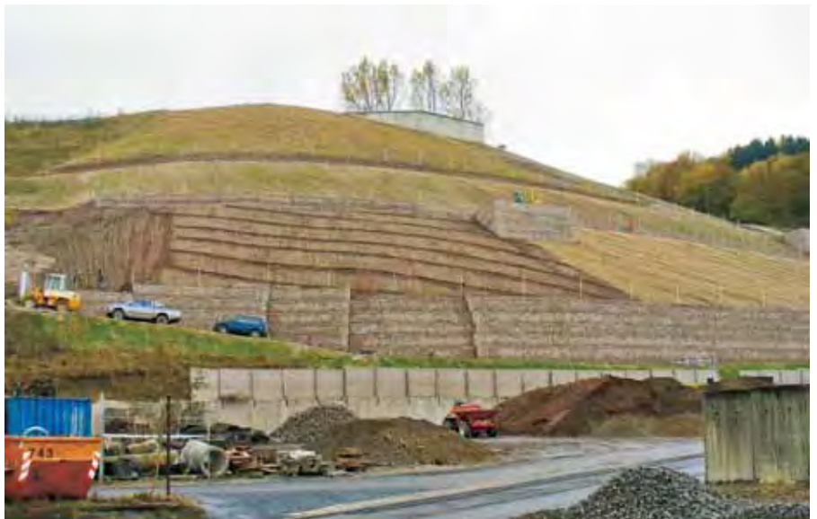
Sanierung der Halde 278 in Schwarzenberg-Grünstädtel (Foto: Wismut GmbH)
