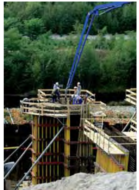
Bau der Schleuse am Überleiter 6 (Foto: LMBV)
