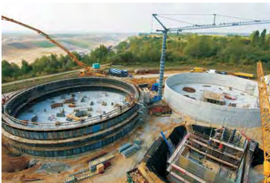
Bau der Grubenwasserreinigungsanlage am Tagebau Vereinigtes Schleenhain (Foto: MIBRAG mbH)
